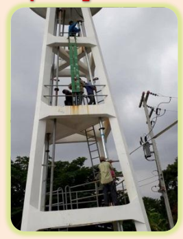
“องค์การบริหารส่วนตำบลลำคองห์ ดำเนินการเปลี่ยนท่อส่งน้ำที่ชำรุด เพื่อให้สามารถดำเนินการสูบน้ำและผลิตน้ำประปาได้อย่างต่อเนื่อง...(อ่านต่อด้านใน)”
